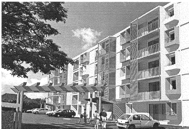
Vue de façade du bâtiment L après travaux
