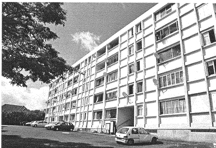
Vue de façade du bâtiment L avant travaux
